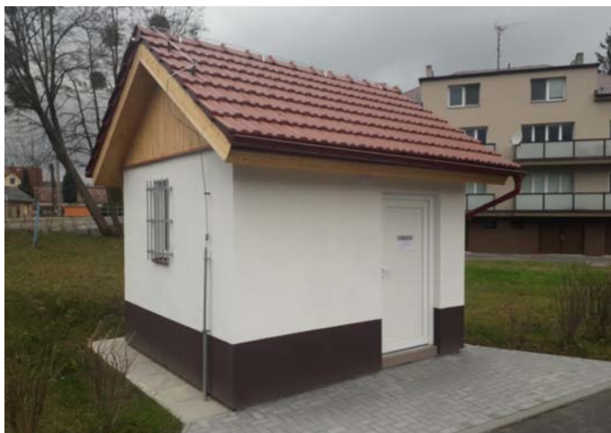
Tlaková stanice k vodovodu
